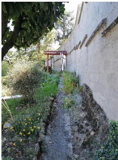
PORTAIL AMONT SITUE SUR LE CHEMIN RURAL
